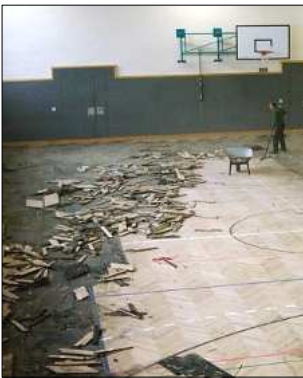
Am 17.10.2005 wurde das alte Parkett in der Turnhalle entfernt.
